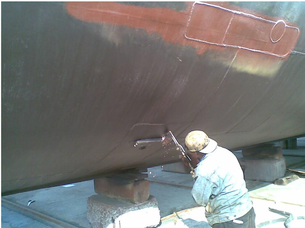
Figura 7.- Corte de un ánodo de zinc
