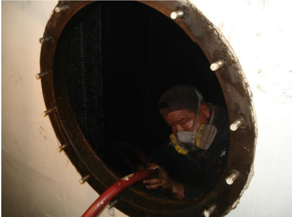
Figura 15.- Limpieza de un tanque de combustible
