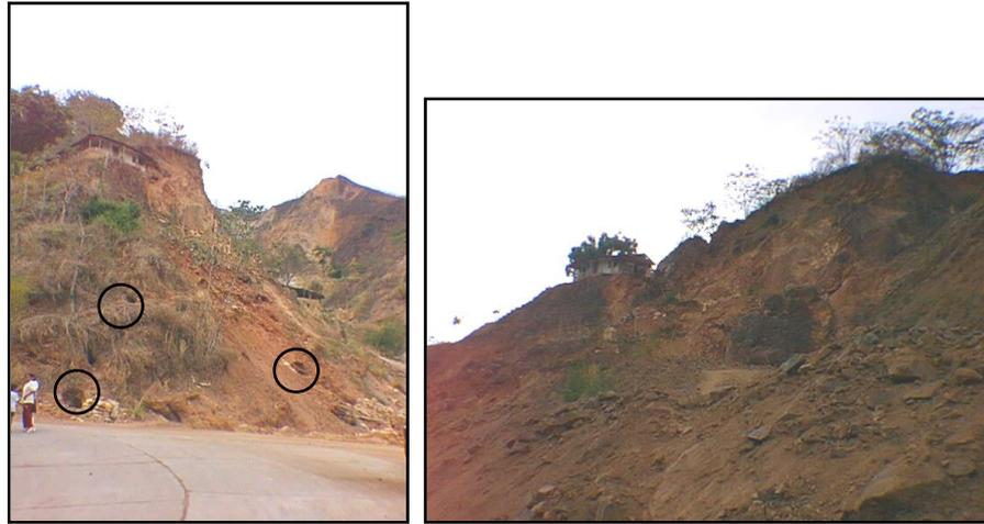
**Fig. 1.8.** Laderas de explotación sin medidas de control de riesgo.
