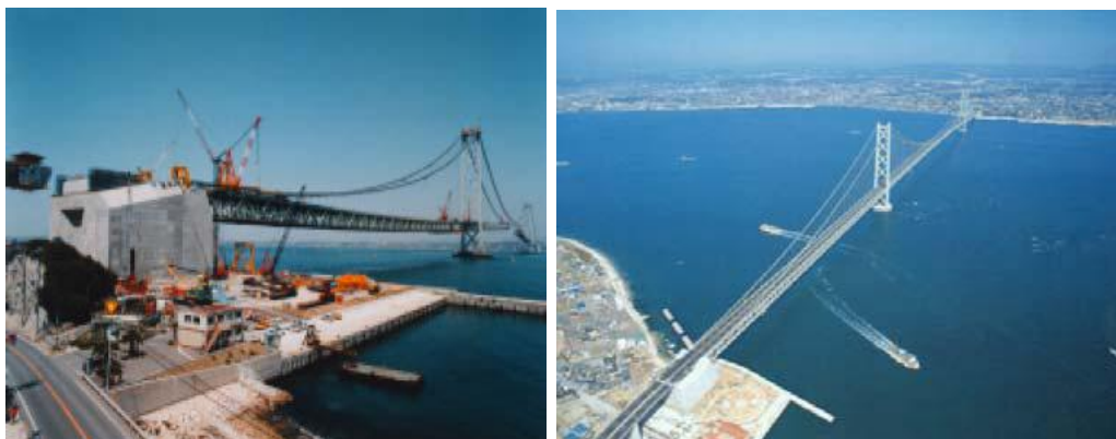
FIGURA 1.1. ANCLAJE DEL PUENTE AKASHI KAIKYO
