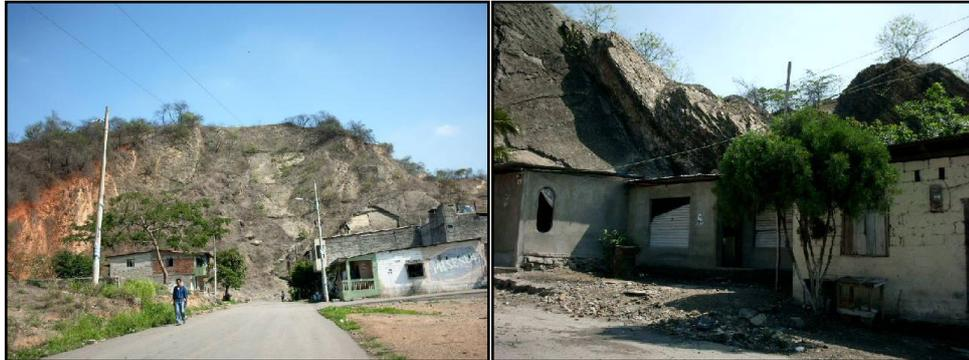
**Foto 23 y 24.-** Sector propenso a deslizamientos en sentido del buzamiento, afortunadamente el alto grado de coherencia elimina ésta posibilidad. La foto de la izquierda muestra el remanente de la explotación que hubo en el área. La foto de la derecha muestra la panorámica del sector (Ferroviaria) donde en primer plano se observa el horizonte de meteorización.
