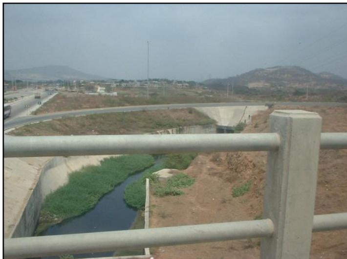
**Foto 26.-** Canal de descarga, con tramos de ducto cajón para drenaje de Las Orquídeas y sectores aledaños.
