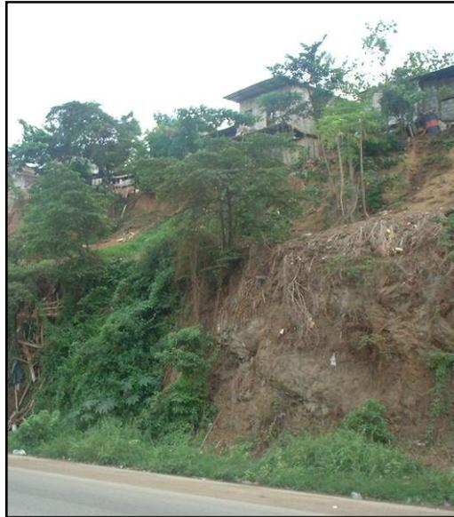
**Foto 10.-** Talud colindante con la Vía Perimetral, se observa las casas construidas en el borde del mismo. Sitio de potencial peligrosidad
