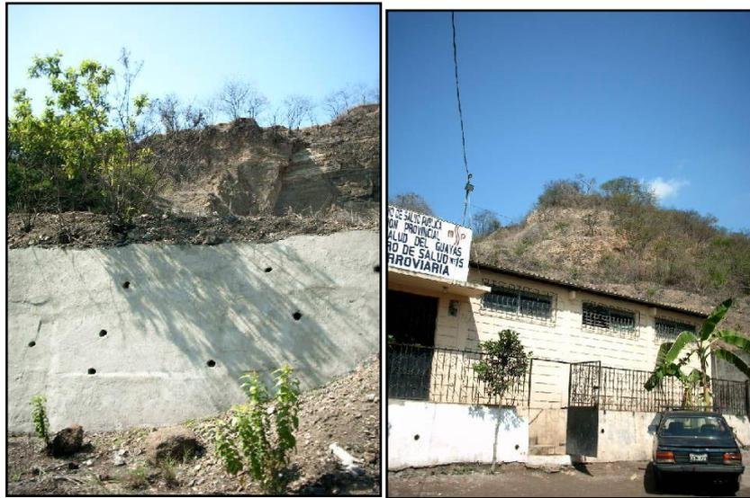
**Foto 21.-** Obsérvese la superficie de hormigón en la parte baja de la ladera Norte. A la izquierda, Centro de Salud Ferroviaria, que está construido frente a ladera Norte en cuyo patio de observa acumulación de sedimentos.
