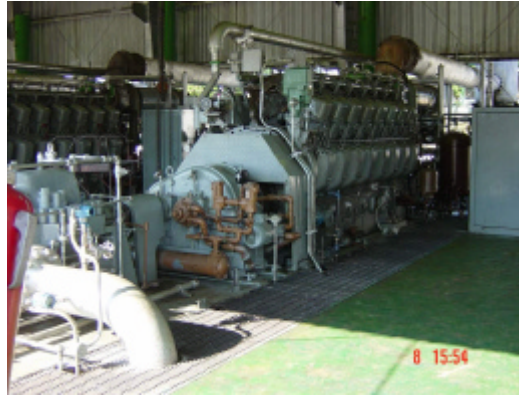
Fig. 2 .- Unidad de Bombeo
