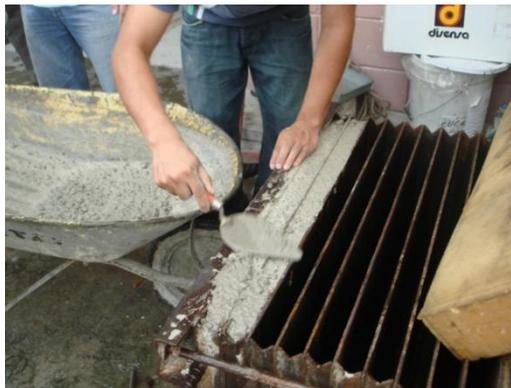
**FIGURA 5.5 Retirada de hormigón sobrante**
