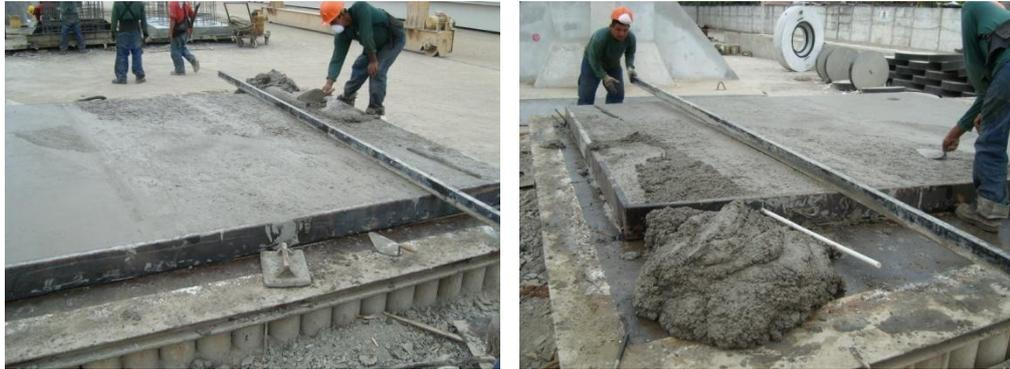
**FIGURA 5.19 Enrasa-miento y alisado final del panel**
