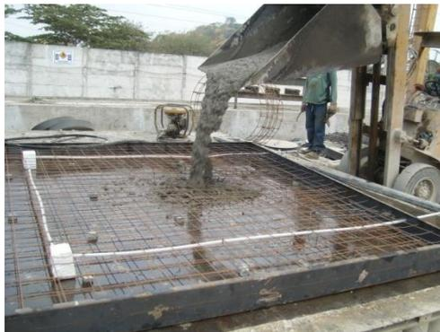
**FIGURA 5.17 Transporte del Hormigón Liviano mediante el bobcat**
