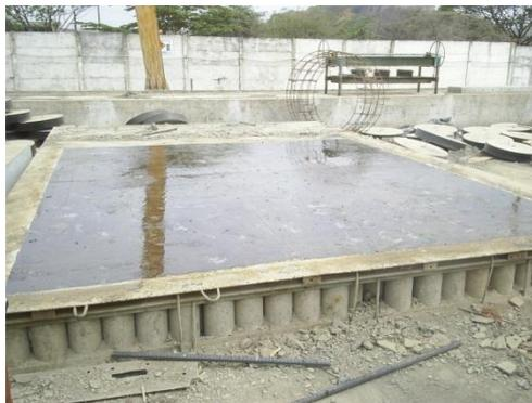
**FIGURA 5.9 Colocación de diesel a la plancha metálica**
