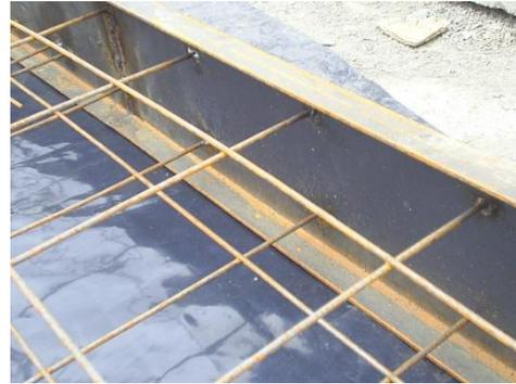
**FIG. 5.8 Soldadura de mallas al perfil**
