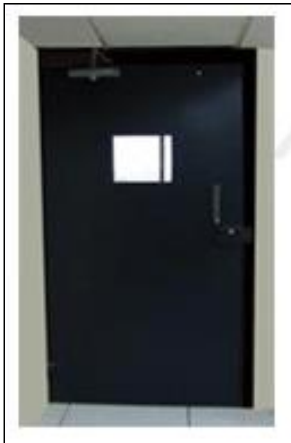
Figura 3.3 – Puerta de Seguridad del Data Center [16]
