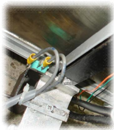
**Figura 52.: Final de Carrera Presionado por la Cabina**
