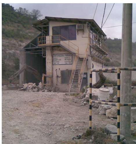
Figura # 4 Subestación "Trituración Primaria"
