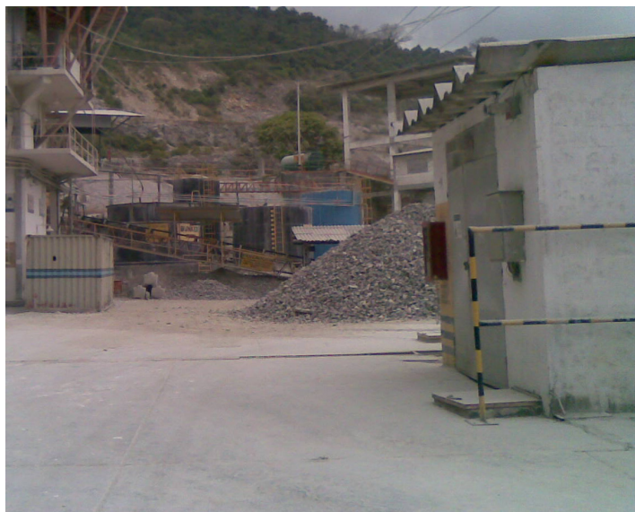
Figura # 12 Subestación “Planta de Cal”
